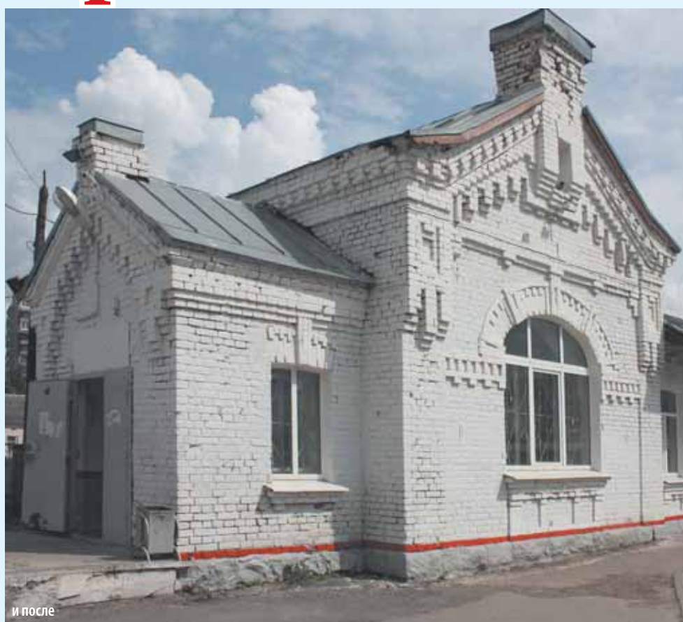
Вокзал железнодорожной станции "Пискаревка" до
